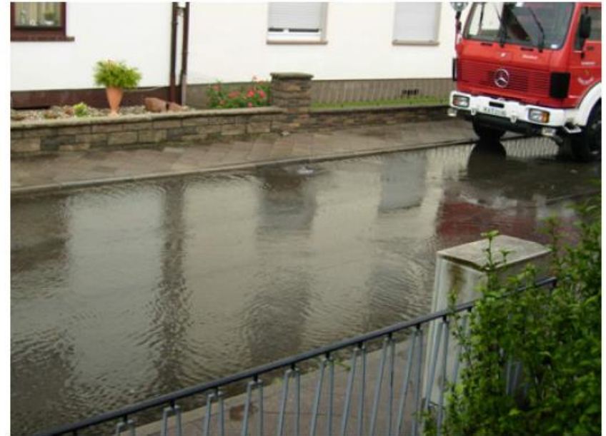
Bild b: Straße 40 Minuten später (keine Schäden)
