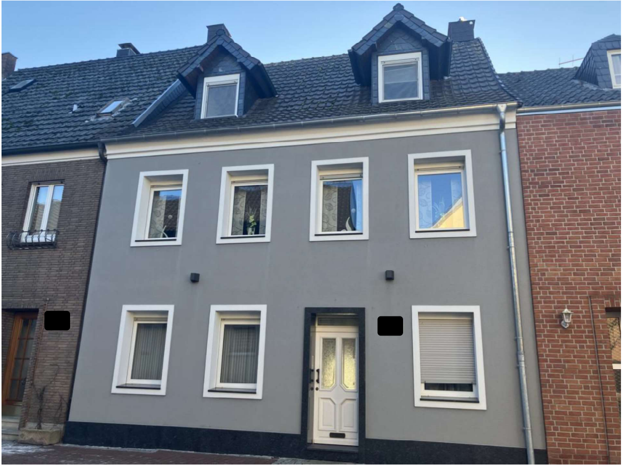
Abbildung 30 | Beispiel für ein Gebäude der Sanierungsstufe „Vollsaniert“. Das äußere Erscheinungsbild der Fassade deutet auf die nachträgliche Anbringung eines Wärmedämmverbundsystems hin. Zusätzlich dazu weisen die neueren Fenster, der Dachzustand und der sanierte Schornstein damit insgesamt auf eine voll umfängliche Sanierung des Gebäudes hin (Quelle: DSK, Ortsbegehung vom 08.01.2024, nachträglich geschwärzt)
