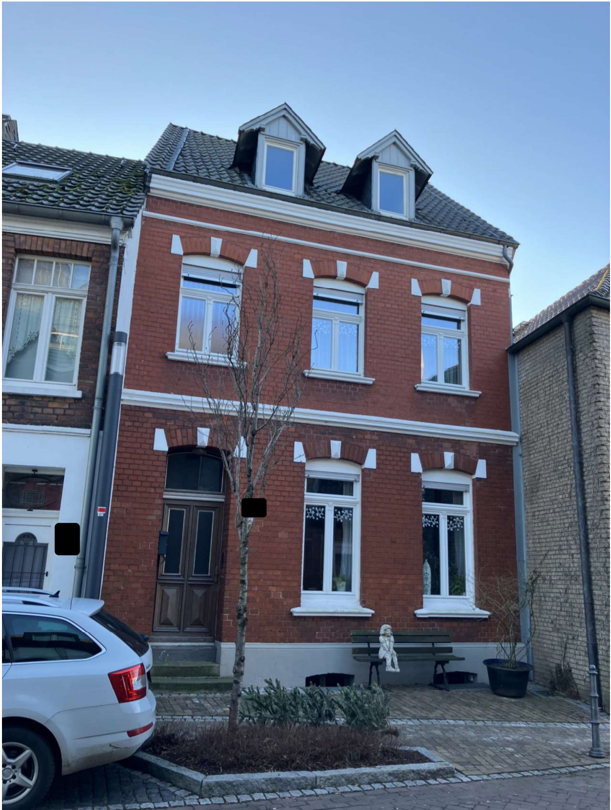
Abbildung 32 | Beispiel für ein Gebäude der Sanierungsstufe „Teilsaniert“. Das Gebäude wurde des Hinweises auf eine Sanierung des Daches in diese Kategorie eingeteilt (Quelle: DSK, Ortsbegehung vom 08.01.2024, nachträglich geschwärzt)
