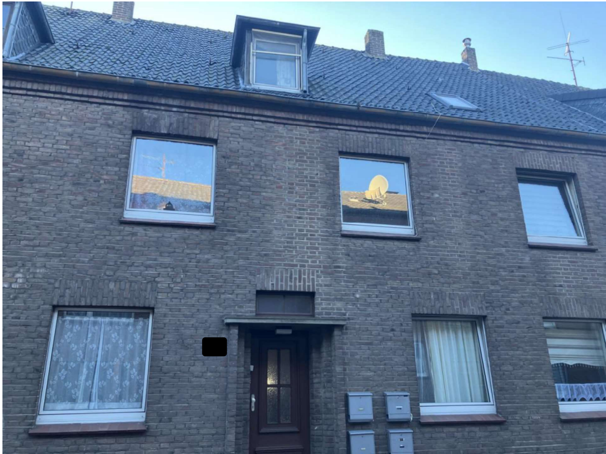
Abbildung 31 | Beispiel für ein Gebäude der Sanierungsstufe „sanierungsbedürftig“. Die Einteilung erfolgte aufgrund des vermuteten Baualters aus den 1950er und dem Fehlen signifikanter Sanierungsmaßnahmen zur Energieeinsparung (Quelle: DSK, Ortsbegehung vom 08.01.2024, nachträglich geschwärzt).
