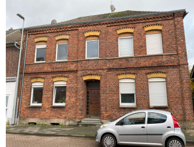
Alte Fenster und Kellerfenster mit geringem Schutz vor Starkregen
