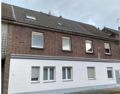
Teilfassadensanierung und alte Kunststofffenster oben
