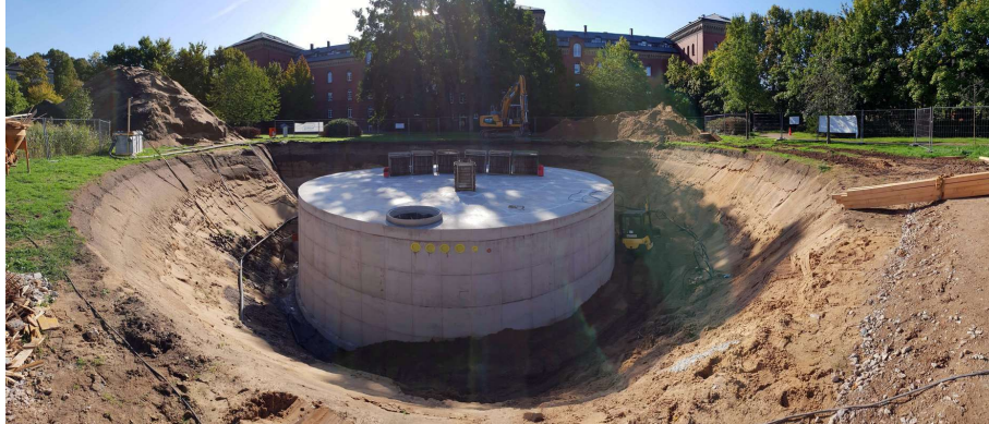
Abbildung 70: Exemplarische Darstellung eines Eisspeichers 33 (Quelle: Siehe Fußnote)
