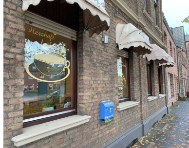
Holzrahmen- und Fenster am Gewerbe
