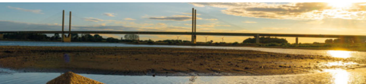
Rheinbrücke bei Rees
