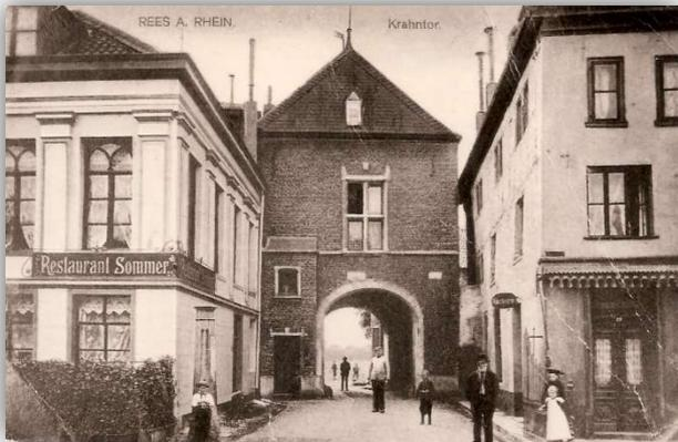
Das Krantor, ein Fahrzeug-Tor mit tonnenartig gewölbter Decke und mächtigem Turm, wurde 1540 erbaut. Seinen Namen erhielt es auf Grund seiner Öffnung zur Schiffsanlegestelle, an welcher die Schiffe mit einem großen Kran be- und entladen wurden. Im Turm, der über eine Innentreppe zu erreichen war, befand sich ein großer Raum, in welchem
